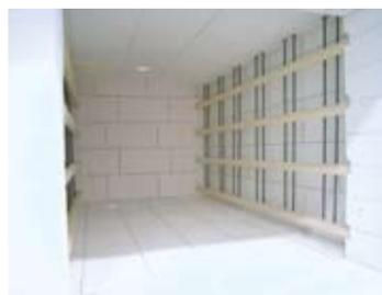
Griglia di protezione davanti agli elementi riscaldanti per la protezione da danni meccanici
